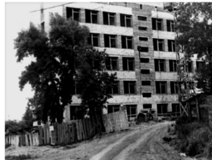
Строящееся здание крайСЭС, ул. Сопочная, 38
