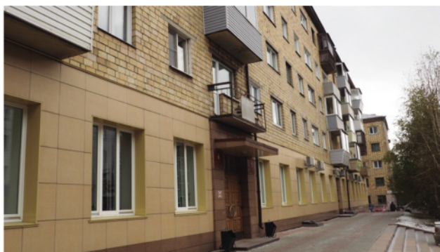
Здание санэпидстанции, ул. Сурикова, 6
