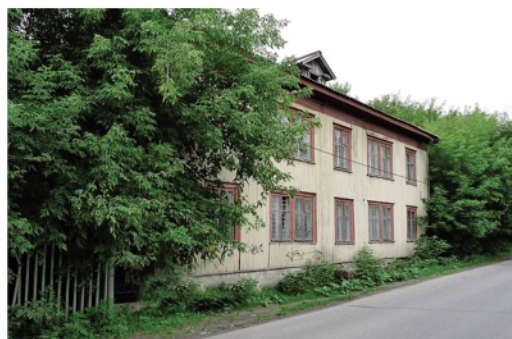
Здание санэпидстанции, ул. Советская, 41
