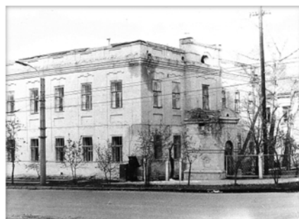
Здание крайСЭС, ул.А.Лебедевой, 16
